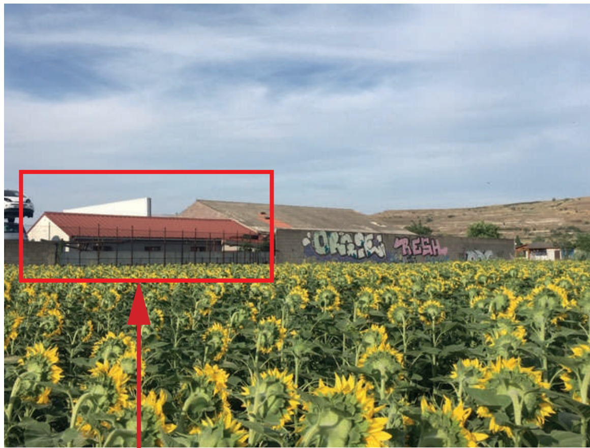
Bâtiment à démolir
